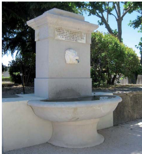
La Fontaine Biscahy rénovée et remise en eau potable
