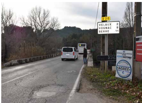
Travaux de sécurisation du Moulin du Pont par le Département
