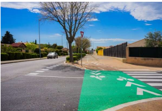
Travaux de voirie 285 000€
