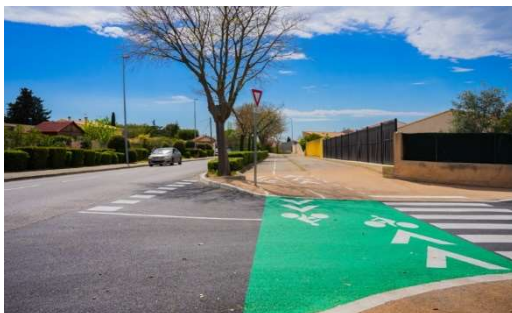
Travaux de voirie
